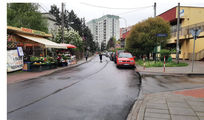
Wyremontowana ul. Kołobrzeska
